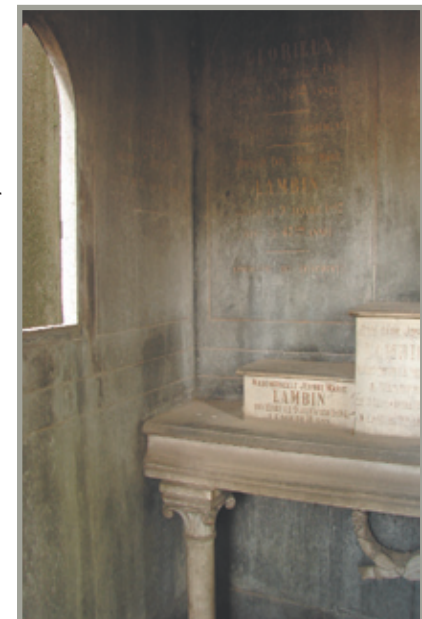
détail 2 : Vue vers le mur de fond de la chapelle
