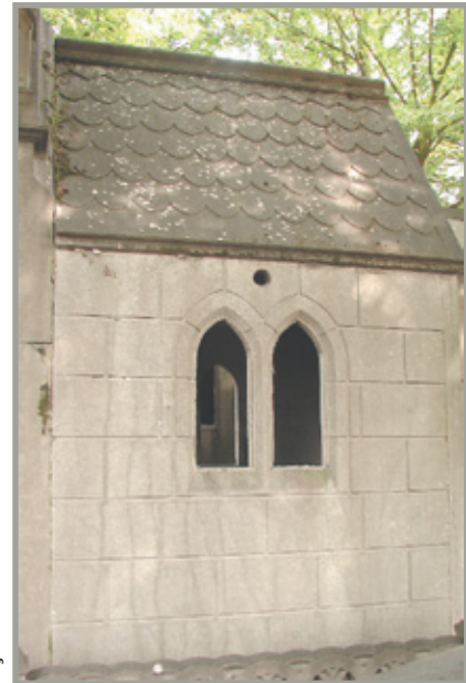
façade latérale droite
