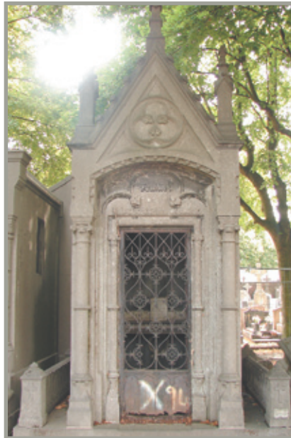
façade principale sur allée
